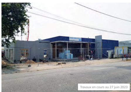
Travaux en cours au 27 juin 2023
